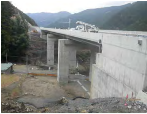
白沢川高架部
