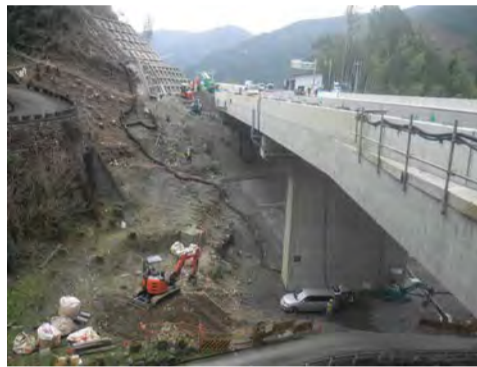
唐沢川高架部
