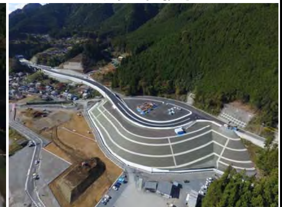
川合工区状況
