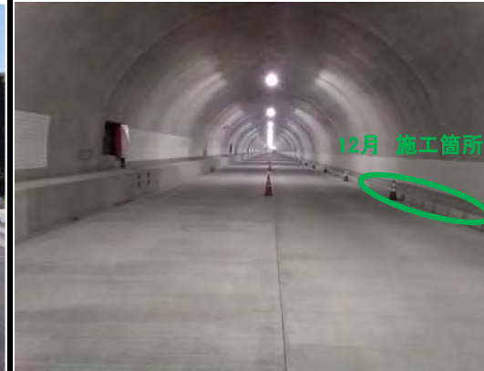
トンネル坑内(満川⇒川合)
