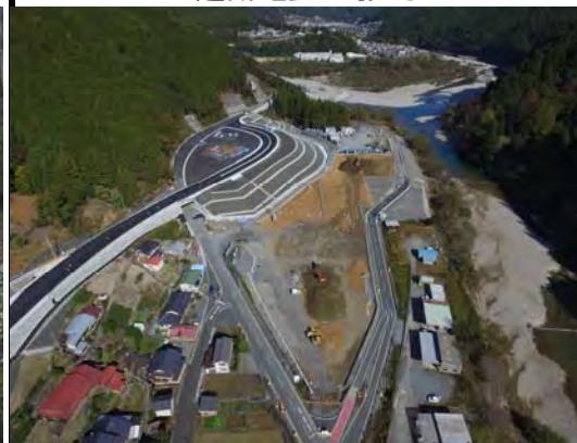
造成地盛土状況
