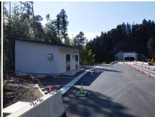
トンネル電気室
