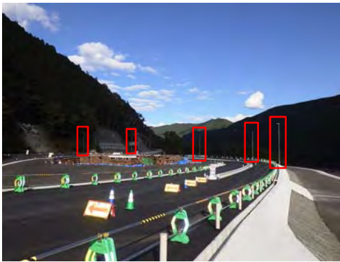
佐久間IC(仮称)照明灯
