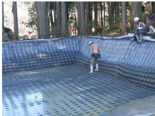
沈砂池(施工中)
