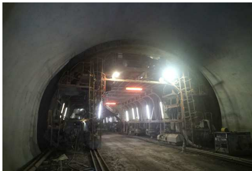
覆工コンクリート
