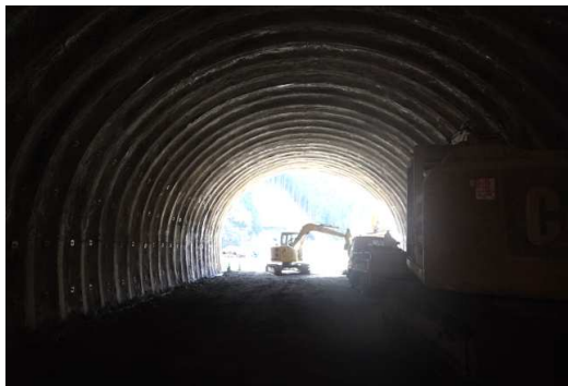
トンネル掘削
