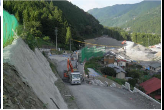
暫定ランプの補強土壁
