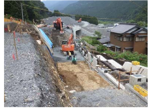
暫定端末ランプの補強土壁
