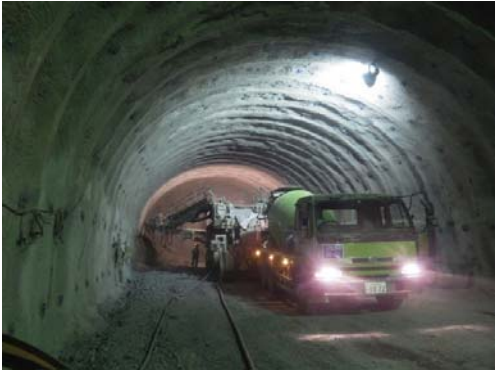
トンネル掘削
