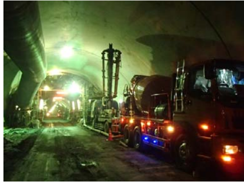
覆工コンクリート
