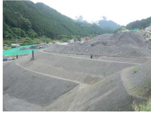
佐久間IC(仮称)の盛土
