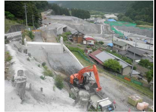
暫定端末ランプの補強土壁
