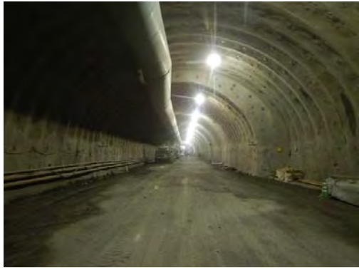
トンネル掘削
