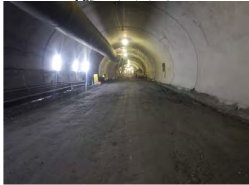
覆工コンクリート
