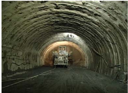
トンネル掘削
