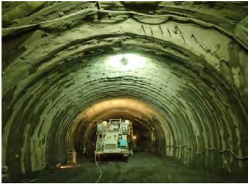
トンネル掘削
