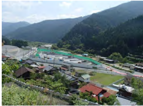
トンネルずい判定場
