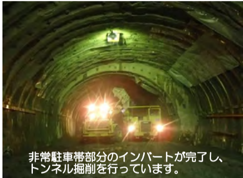
トンネル掘削
