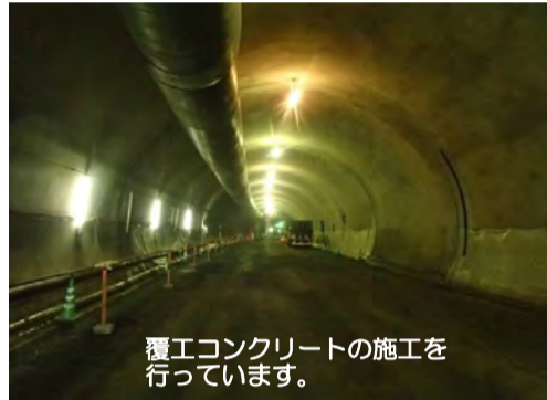
覆工コンクリート
