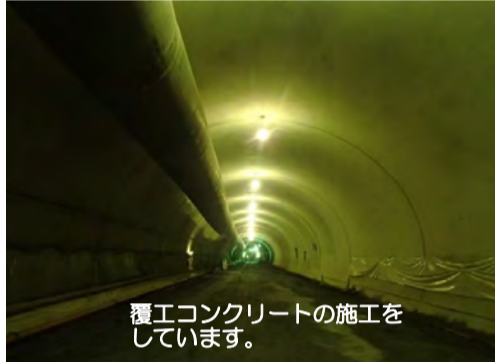
覆工コンクリート
