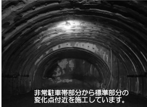
トンネル掘削
