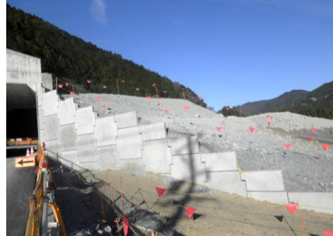
テールアルメ据付完了
