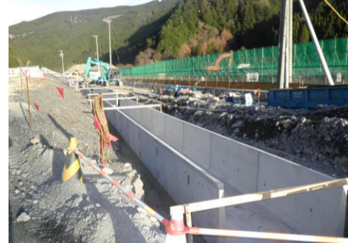
付替水路 施工状況
