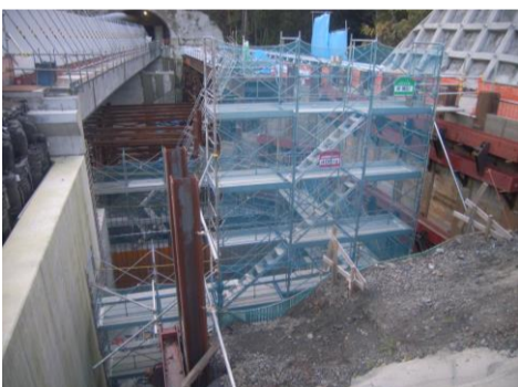
川合1号橋 躯体築造
