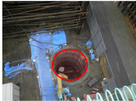
川合2号橋 橋脚深礎杭掘削
