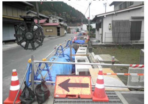
排水工事(24号線)
