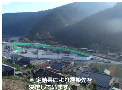
トンネルずり判定場
