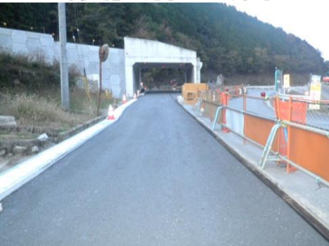
路盤施工完了(BOX周辺)
