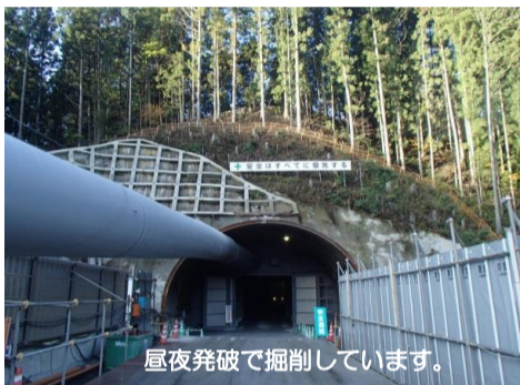
トンネル坑口
