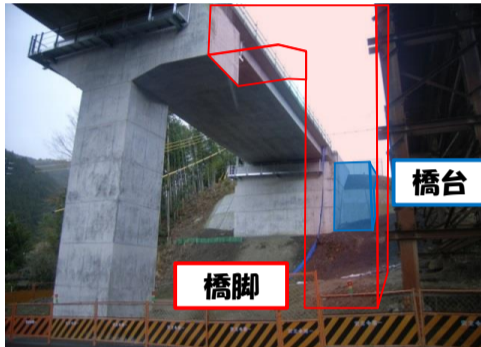
川合2号橋 橋台背面
