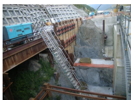
川合1号橋深礎杭進捗状況
