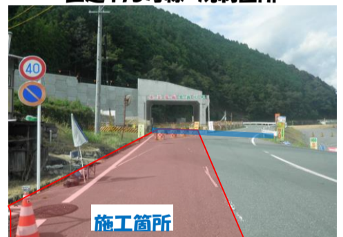
国道473号線 規制箇所
