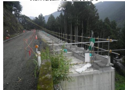
防護柵基礎 据付完了
