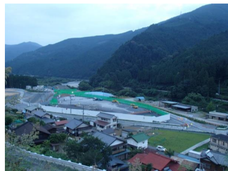
トンネルずり判定場
