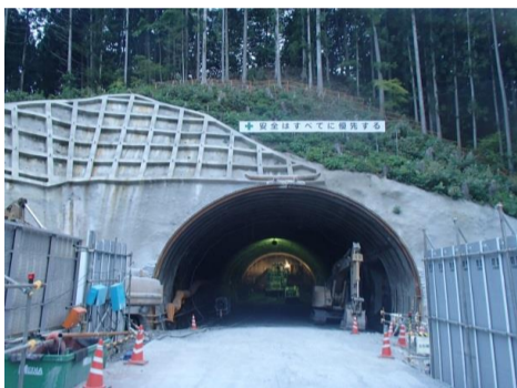
トンネル坑口
