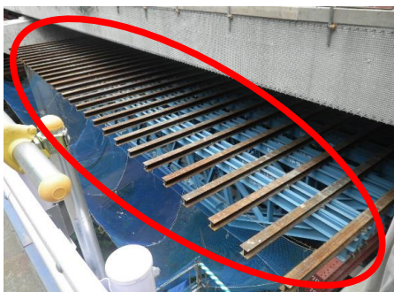
川合1号橋下部 仮設材撤去
