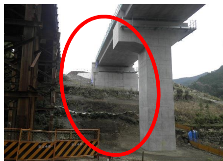
川合2号橋 橋台・橋脚築造予定
