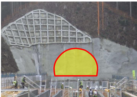
トンネル坑口位置
