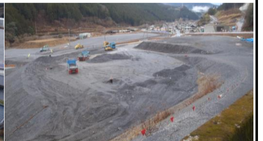
国道473号から端末ランプを撮影
