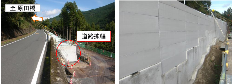
施工箇所 国道473号
