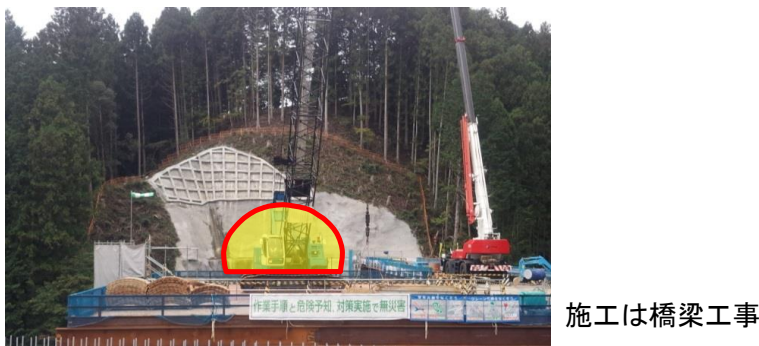
トンネル坑口位置
