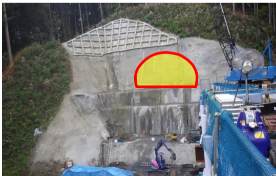
トンネル坑口位置
