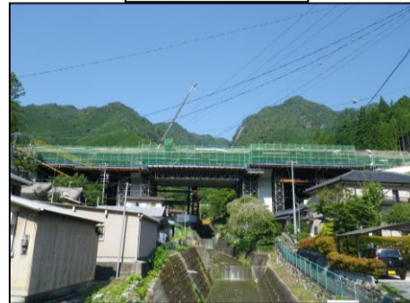
下流側から撮影
