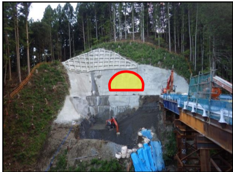
トンネル坑口位置
