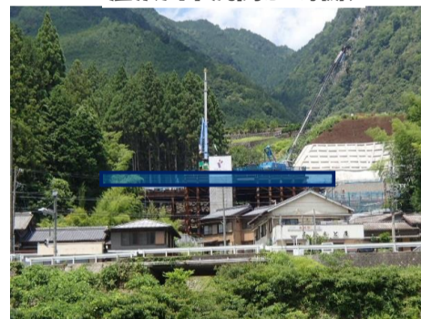
唐沢川下流側から撮影
