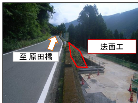
施工箇所 国道473号
