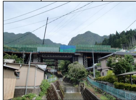
下流側から撮影
