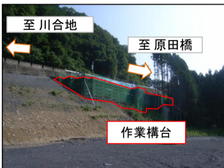
施工箇所 佐久間IC(仮称)
