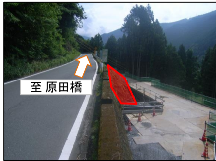
施工箇所 国道473号
