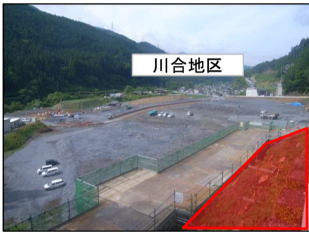
施工箇所 佐久間IC(仮称)
