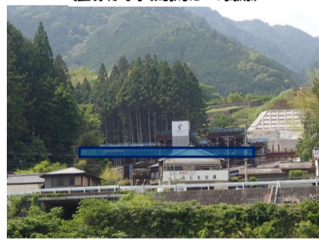
唐沢川下流側から撮影
