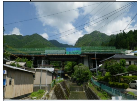
白沢川下流側から撮影
