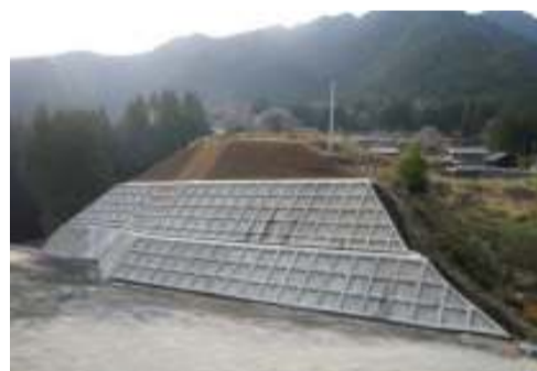
施工箇所南側より北側を撮影
