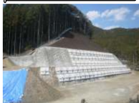
本線部土工事・法面工事 完成
