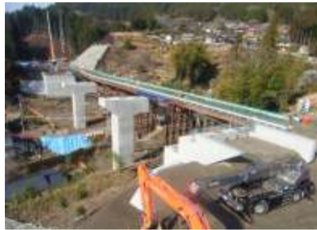
施工箇所写真(東から撮影)
