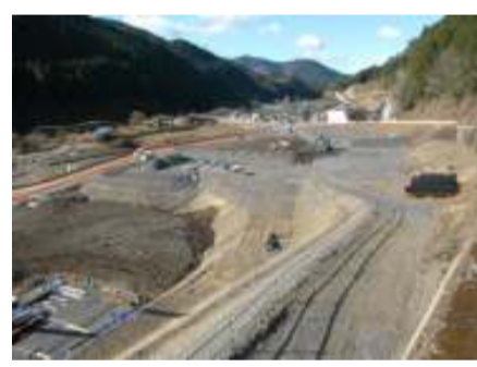
施工箇所 佐久間IC(仮称)
