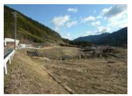
施工箇所 佐久間IC南側(追加ヤード)
