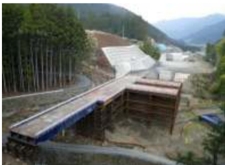
施工箇所西側より東側を撮影
