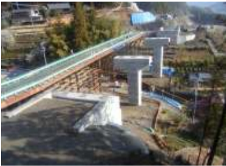
施工箇所写真(西から撮影)
