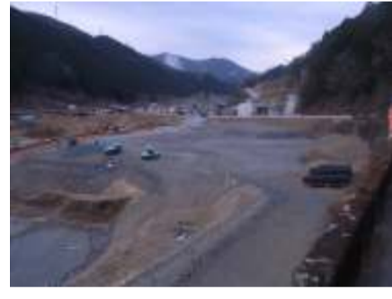
施工箇所 佐久間IC(仮称)
