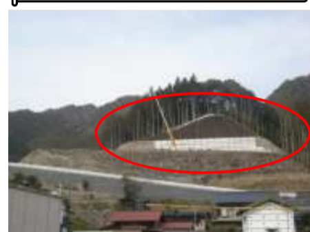
本線部土工事・法面工事施工箇所
