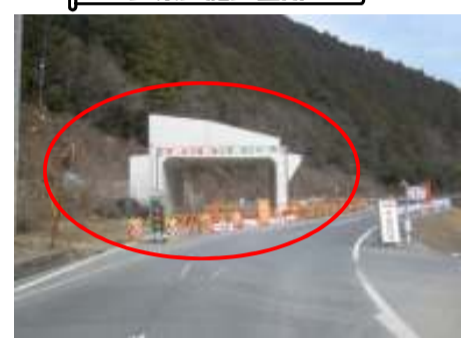
函渠工施工箇所
