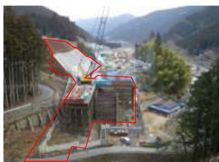
施工箇所東側より撮影
