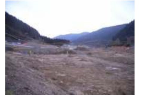
施工箇所 佐久間IC南側(追加ヤード)
