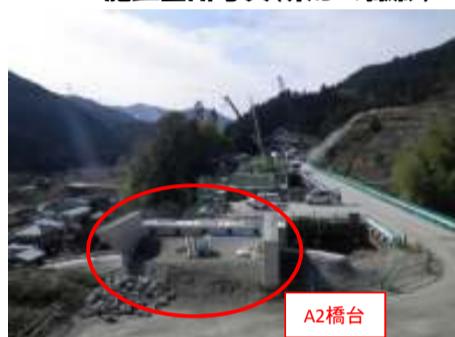
施工箇所写真(東から撮影)
