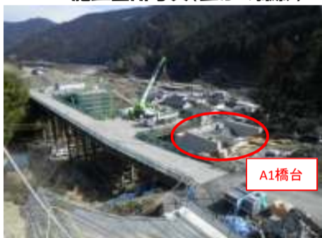
施工箇所写真(西から撮影)
