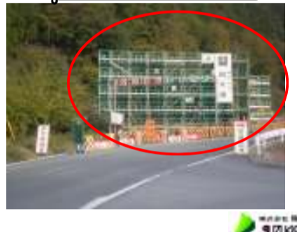
函渠工施工箇所
