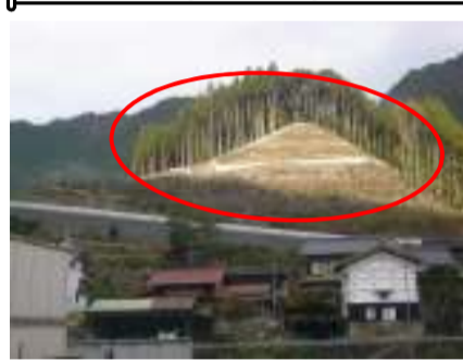
本線部土工事・法面工事施工箇所
