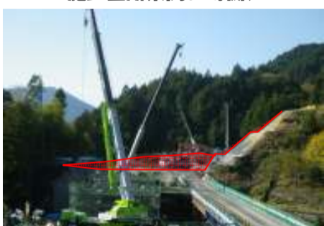
施工箇所東側より撮影
