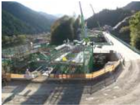
施工箇所写真(東から撮影)
