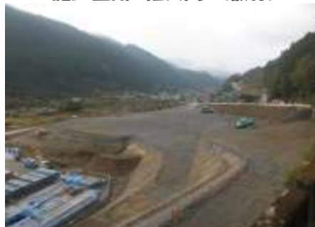
施工箇所 佐久間IC(仮称)
