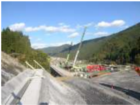
施工箇所写真(西から撮影)
