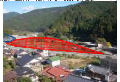
施工箇所 佐久間IC南側(追加ヤード)
