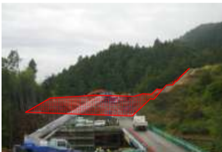
施工箇所東側より撮影
