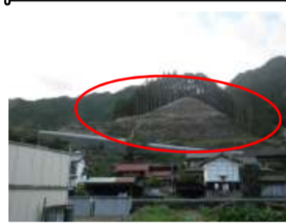
本線部土工事・法面工事施工箇所
