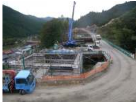
施工箇所写真(東から撮影)
