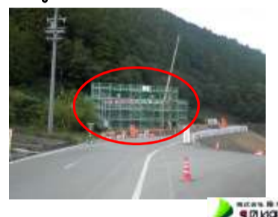
函渠工施工箇所
