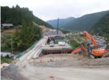
施工箇所写真(西から撮影)
