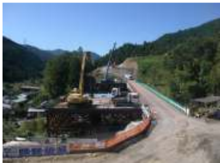
施工箇所写真(東から撮影)
