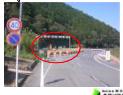
函渠工施工箇所
