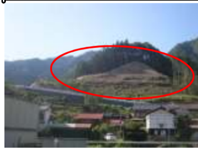
本線部土工事・法面工事施工箇所
