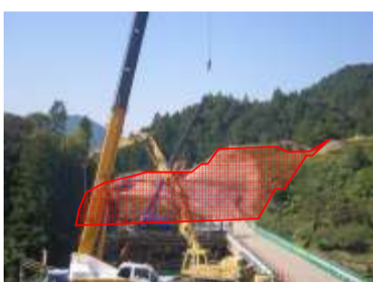
施工箇所東側より撮影
