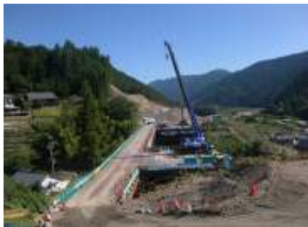
施工箇所写真(西から撮影)
