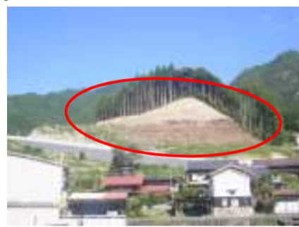
本線部土工事・法面工事施工箇所
