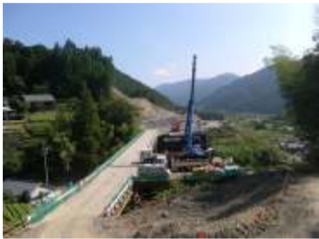
施工箇所写真(西から撮影)
