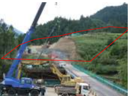
施工箇所東側より撮影
