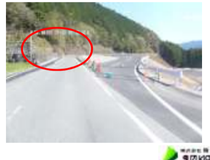
函渠工施工箇所
