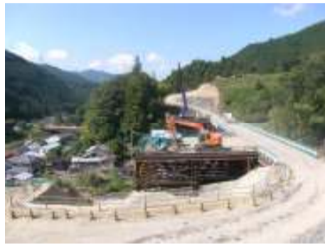
施工箇所写真(東から撮影)
