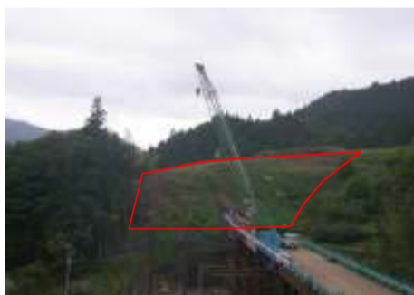
施工箇所東側より撮影
