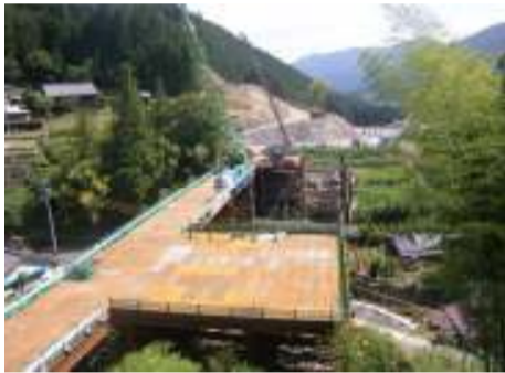
施工箇所写真(西から撮影)
