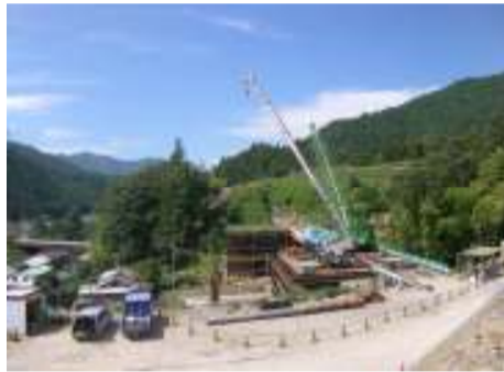
施工箇所写真(東から撮影)
