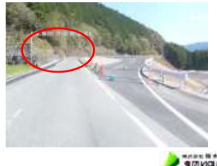
函渠工施工箇所
