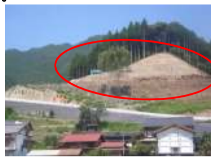
本線部土工事・法面工事施工箇所
