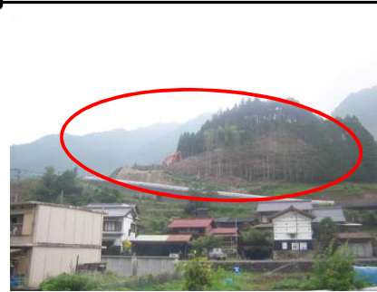
本線部土工事・法面工事施工箇所
