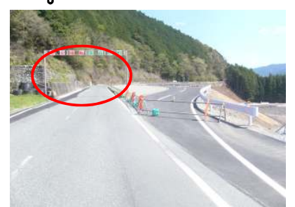
函渠工施工箇所
