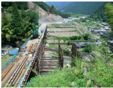
施工箇所写真(西から撮影)
