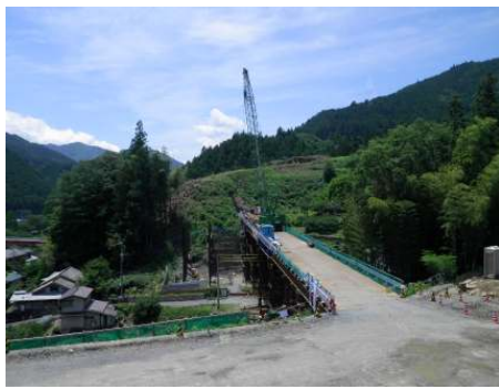
施工箇所写真(東から撮影)
