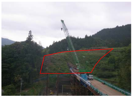
施工箇所東側より撮影
