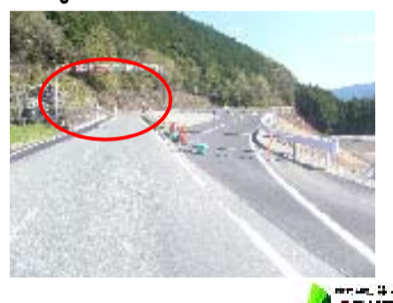
函渠工施工箇所
