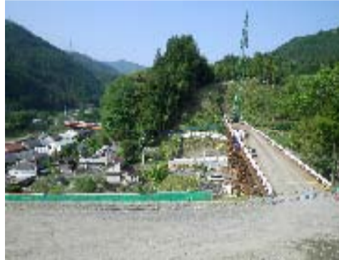
施工箇所写真(東から撮影)
