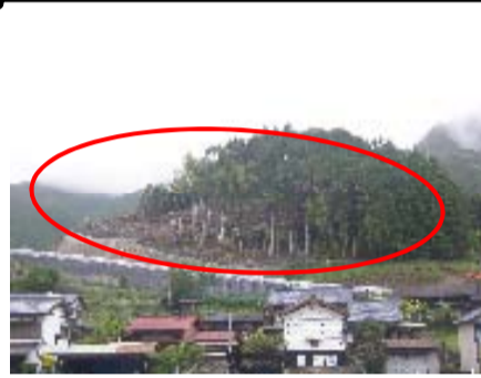
本線部土工事・法面工事施工箇所
