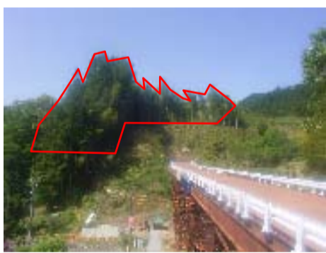
施工箇所東側より撮影
