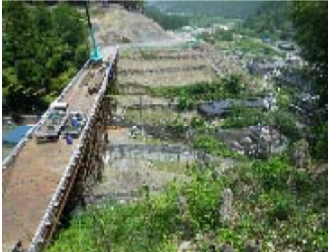
施工箇所写真(西から撮影)
