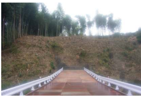
施工箇所東側より撮影
