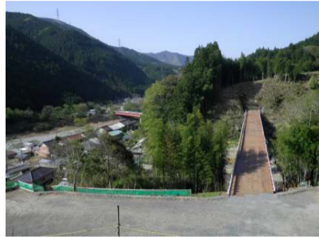
施工箇所写真(東から撮影)
