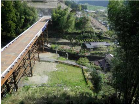
施工箇所写真(西から撮影)
