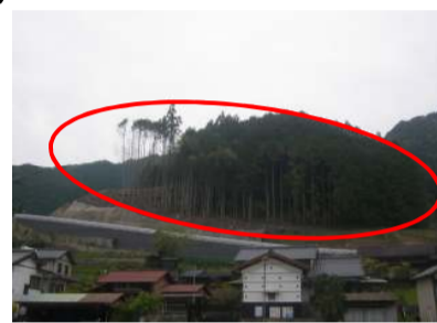
本線部土工事・法面工事施工箇所
