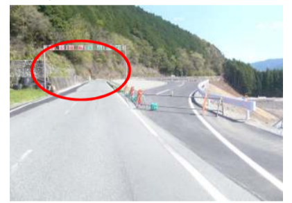
函渠工施工箇所
