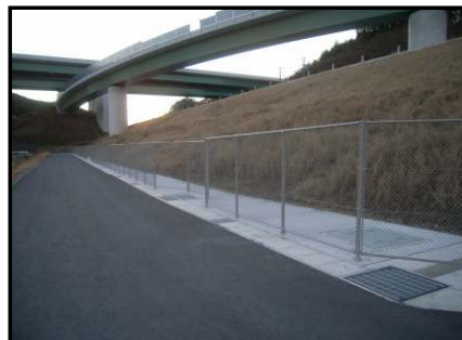
【平田2号線】張コンクリート・立入防止柵
