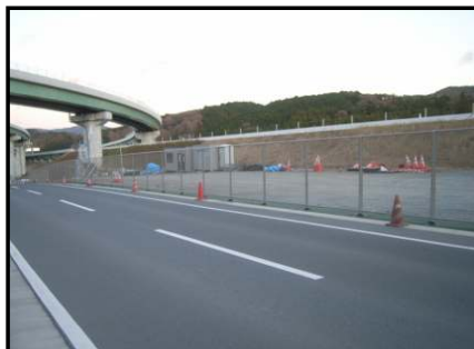
【引佐六郎沢線】張コンクリート・立入防止柵
