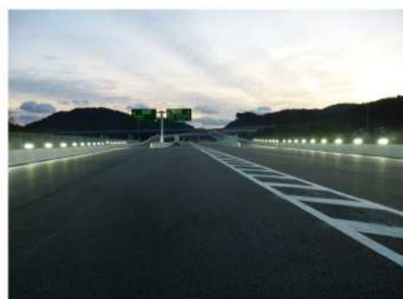
東黒田高架橋(引佐側を望む)
