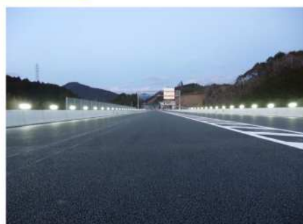
東黒田高架橋(鳳来側を望む)
