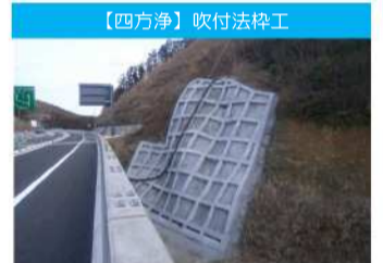
【四方浄】吹付法砕工
