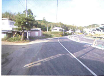
引六線 歩道完了
