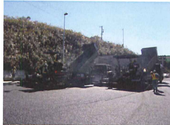
本線表層 施工状況
