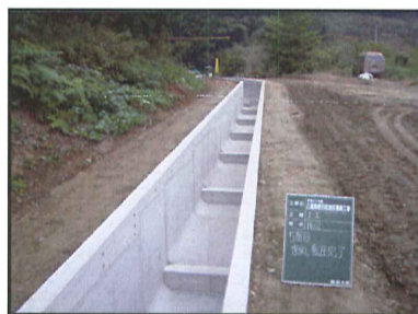
【珍撓工区】三面水路
