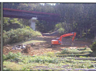
【四方浄工区】進入路撤去
