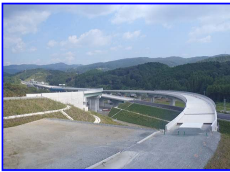
【ランプ橋全景】
