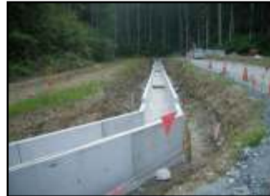
三面水路掘付完
