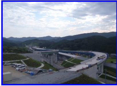
【ランプ橋全景】
