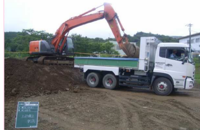
残土積込状況
