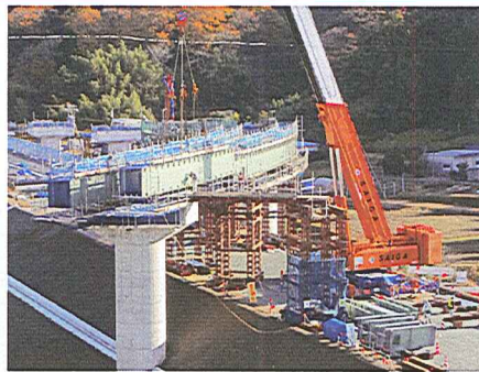
地上で橋桁2本をつないで、360t油圧式クレーンで架設しています。
