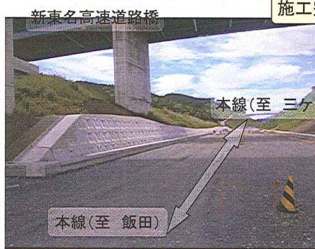
コンクリートブロック積み (新東名高速道路橋交差部分)
