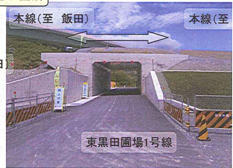
現場打ボックスカルバート (本線と東黒田圃場1号線交差部分)
