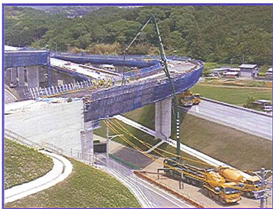
[床版工事 施工全景]
