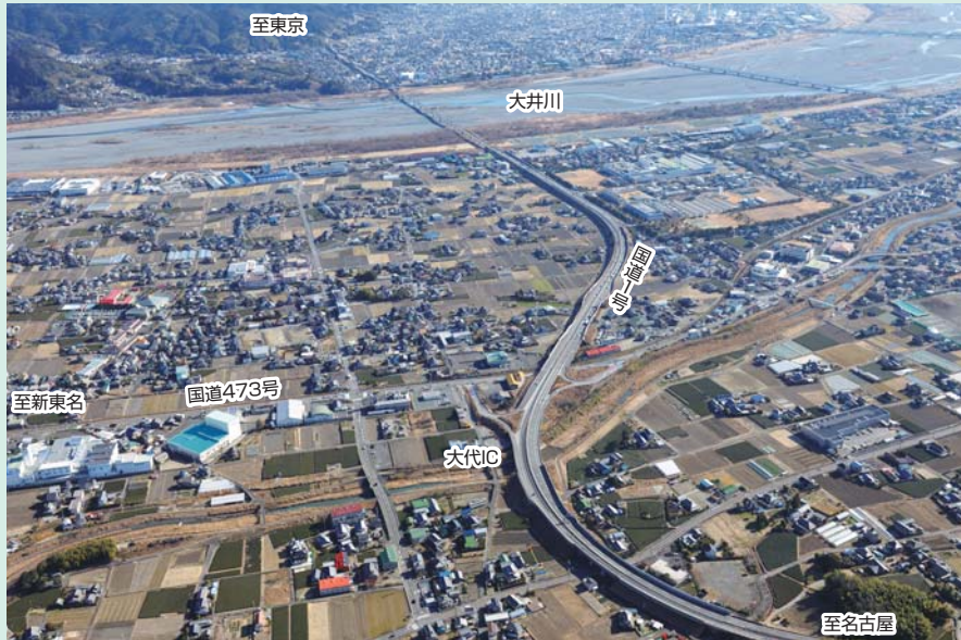
大代IC付近より東京方面を望む(平成24年11月撮影)
