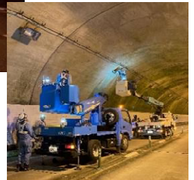
(トンネル照明更新)
