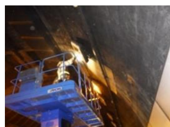
（道路施設の点検）
