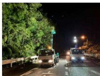
（維持修繕工事）
