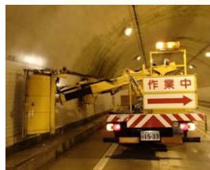
(トンネル内清掃)
