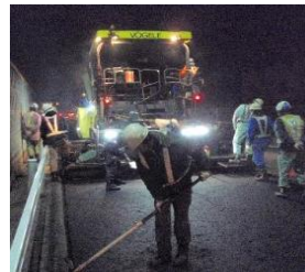
（舗装修繕工事）
