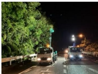
（維持修繕工事）
