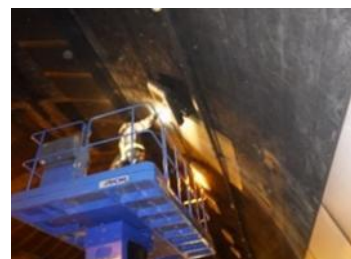
（道路施設の点検）
