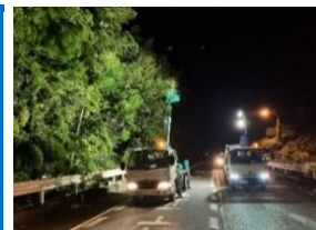
（維持修繕工事）
