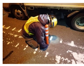
（道路附属物工事）
