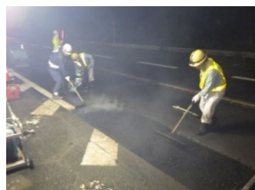
（舗裝修繕工事）
