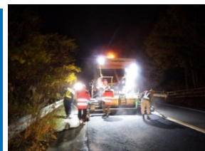
（舗装修繕工事）
